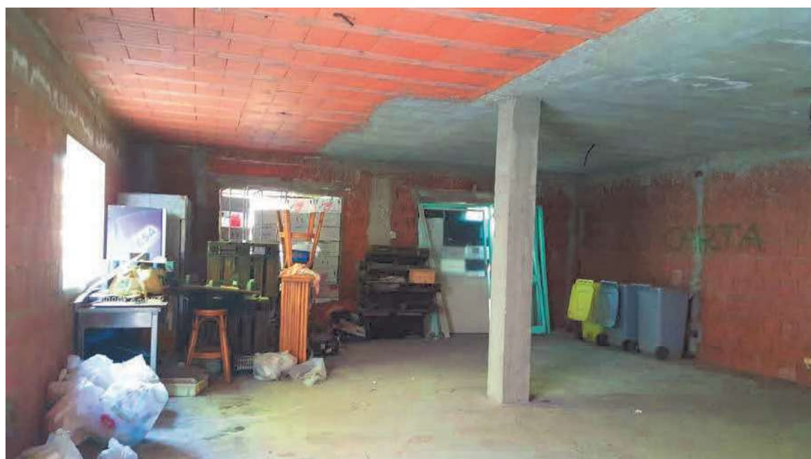
FOTO N.10a – VISTA INTERNA PARTE RICOSTRUITA DEL LOCALE COMMERCIALE
