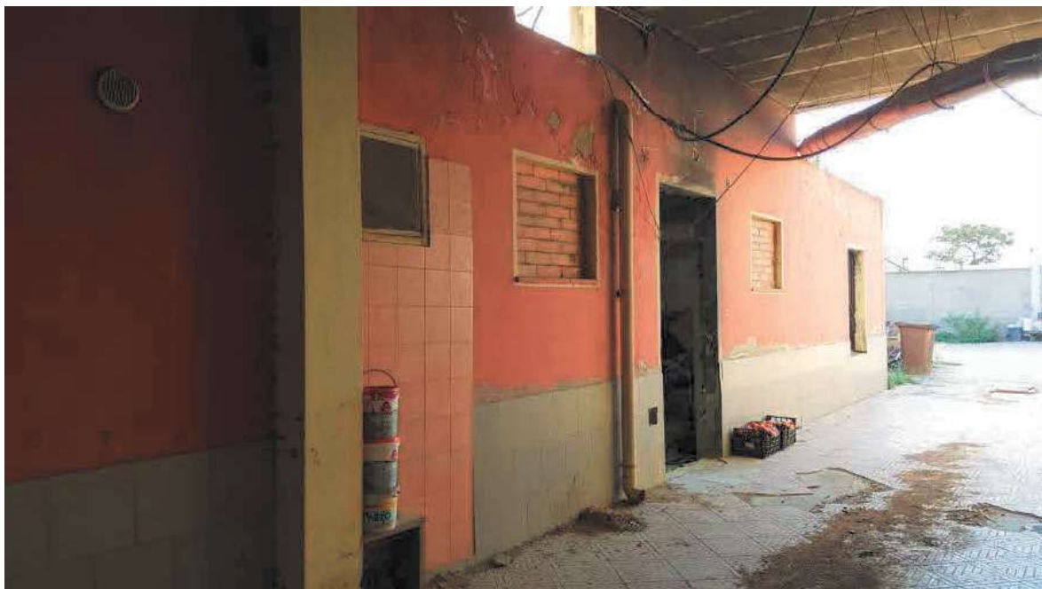
FOTO N.7a – VISTA DEL LOCALE COMMERCIALE E DELL'AMPLIAMENTO
