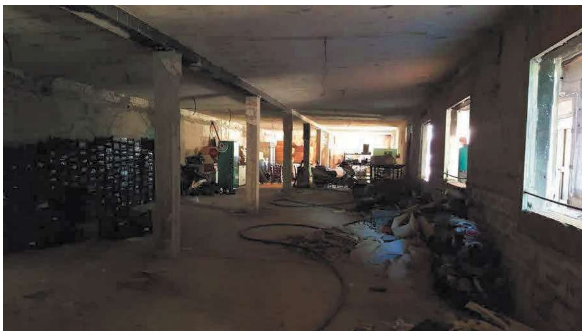
FOTO N.12a – ALTRA VISTA INTERNA DEL LOCALE COMMERCIALE
