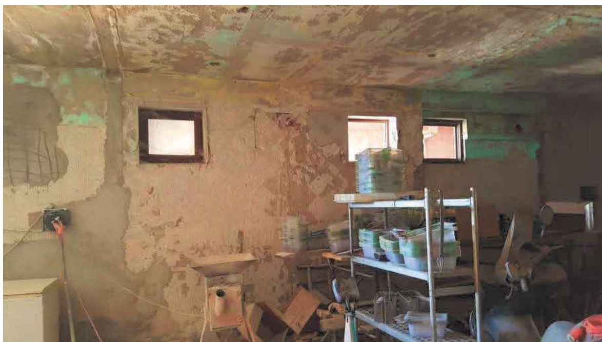
FOTO N.16a – VISTA INTERNA MOSTRANTE I POCHI INFISSI PRESENTI
