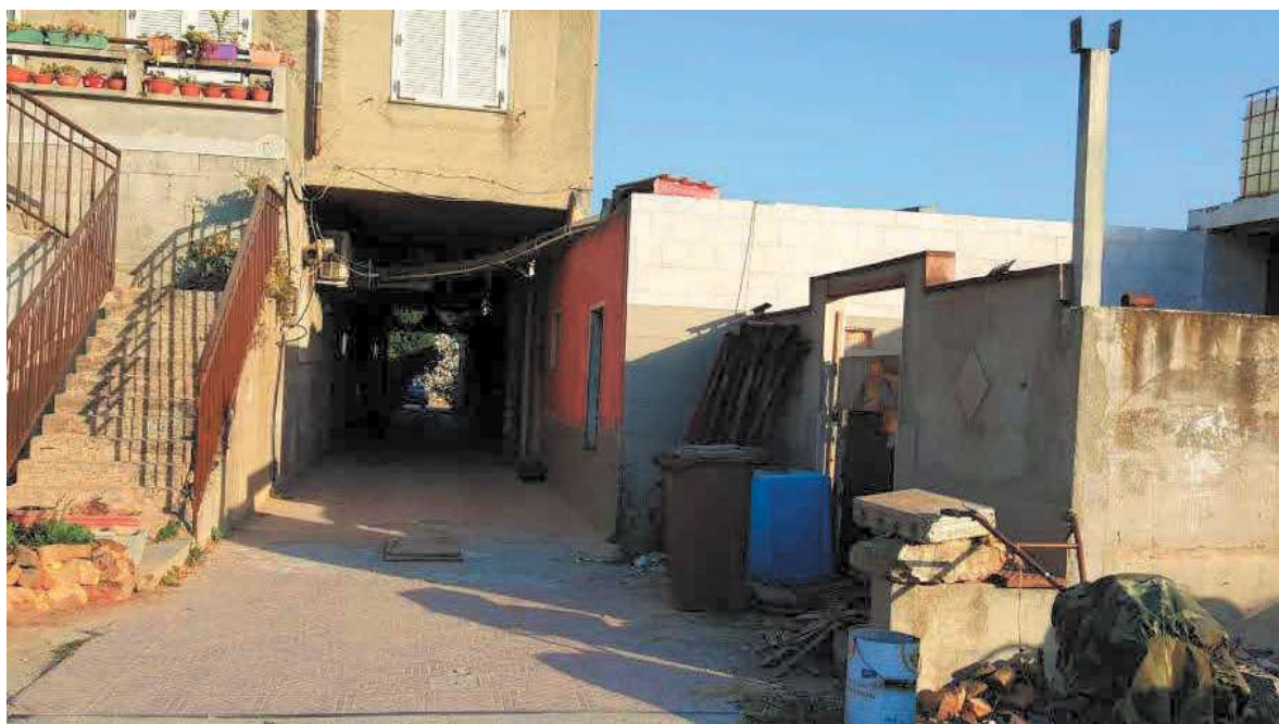
FOTO N.9a – VISTA PARTE RETROSTANTE AL LOCALE COMMERCIALE
