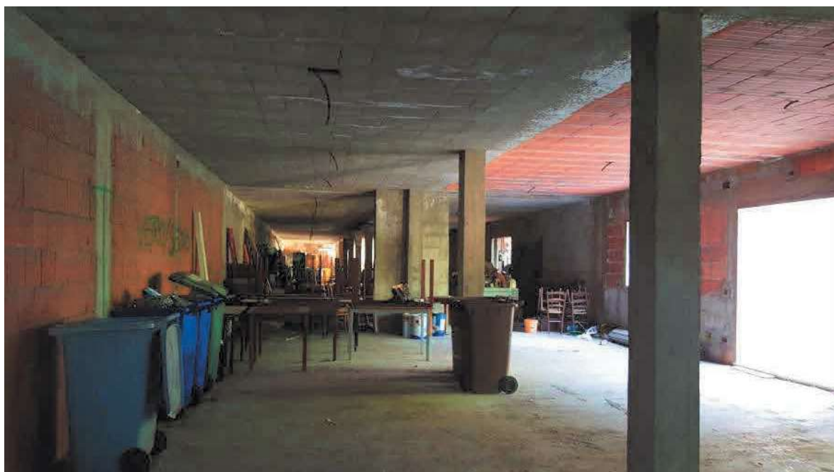
FOTO N.11a – ALTRA VISTA INTERNA DEL LOCALE COMMERCIALE
