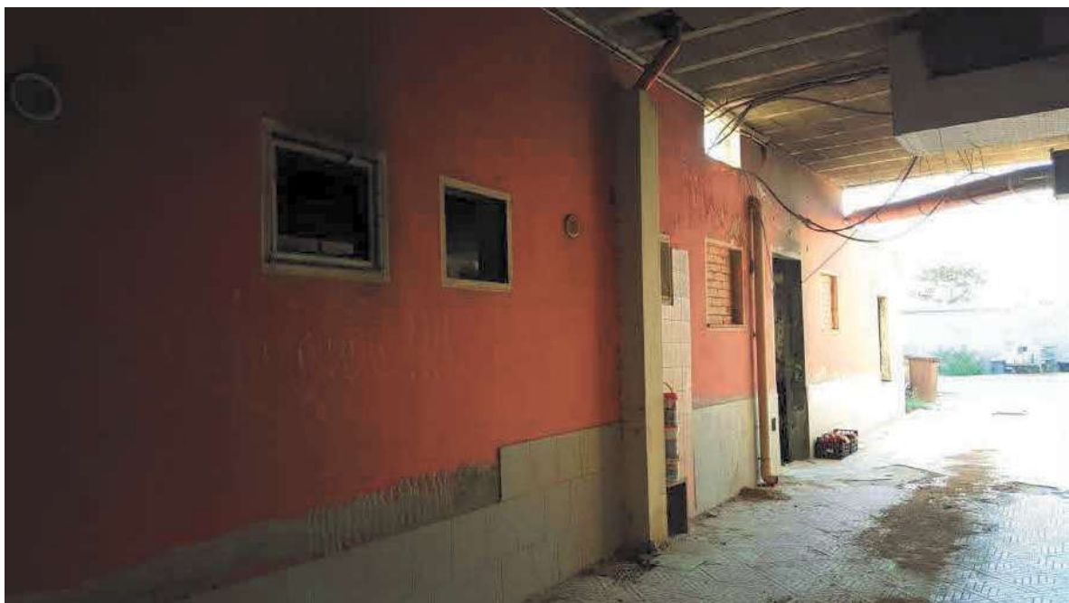
FOTO N.6a – ALTRA VISTA DEL LOCALE COMMERCIALE - LATO NORD/NORD-EST
