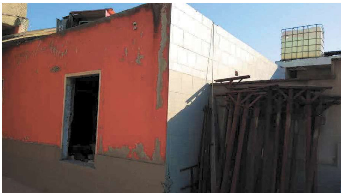
FOTO N.8a – ALTRA VISTA DELL'AMPLIAMENTO
