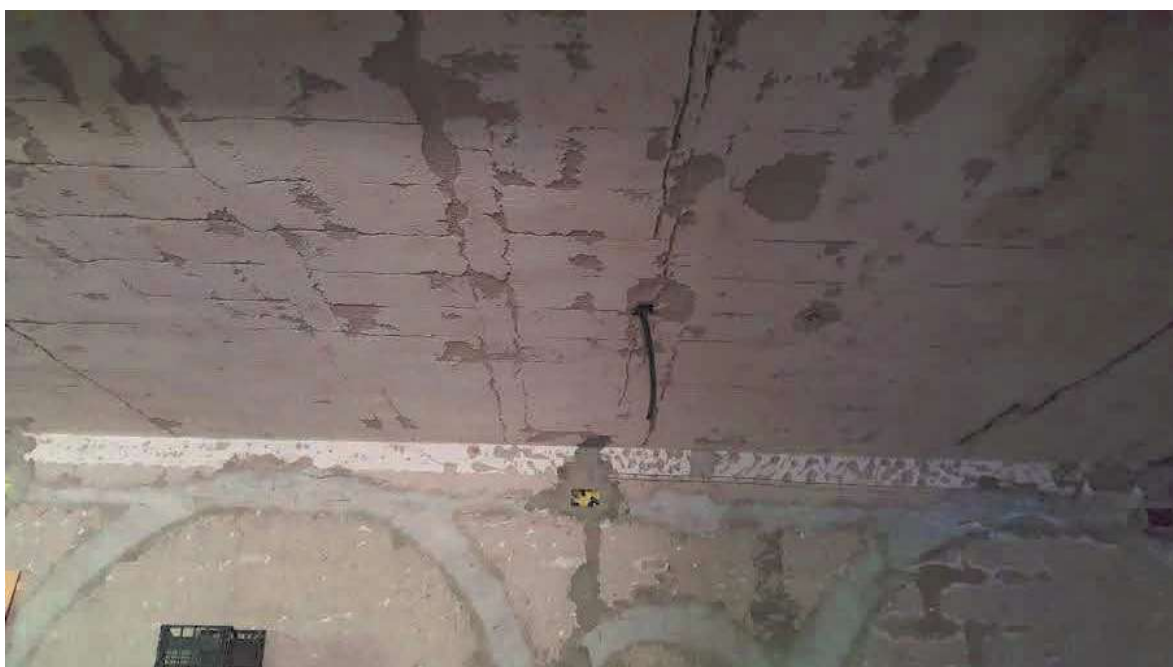
FOTO N.14a – PARTE DI IMPIANTO ELETTRICO PRESENTE ( CORRUGATI E SCATOLE)
