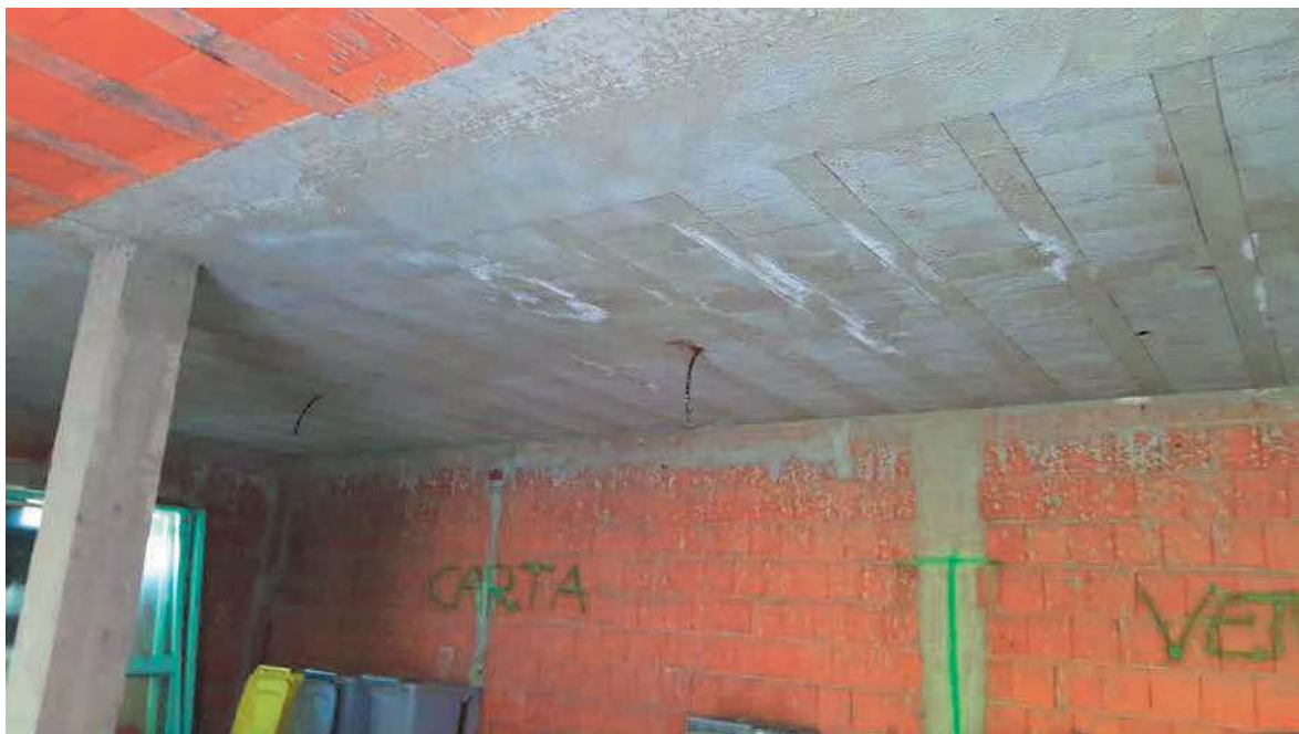
FOTO N.13a – VISTA SOLAIO PARTE RICOSTRUITA
