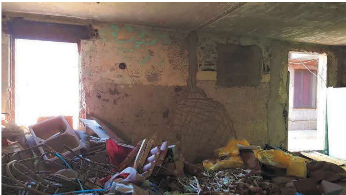
FOTO N.15a – VISTA INTERNA MOSTRANTE ALCUNI VANI FINESTRE PRIVI DI INFISSI
